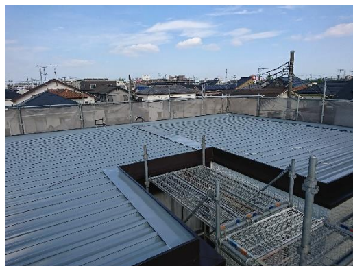
工藤建築板金工業
